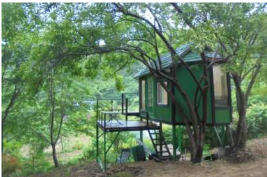
사진의 트리하우스는 플랫폼 방식으로 건물 하부에는 철재로 틀을 짜서 플랫폼을 만든후 그 위에 경량목구조로 지은 건물로써 나무에 구멍을 뚫거나 못을 박은것이 아니므로 수목에는 전혀 부담을 주지 않는 건축방식
